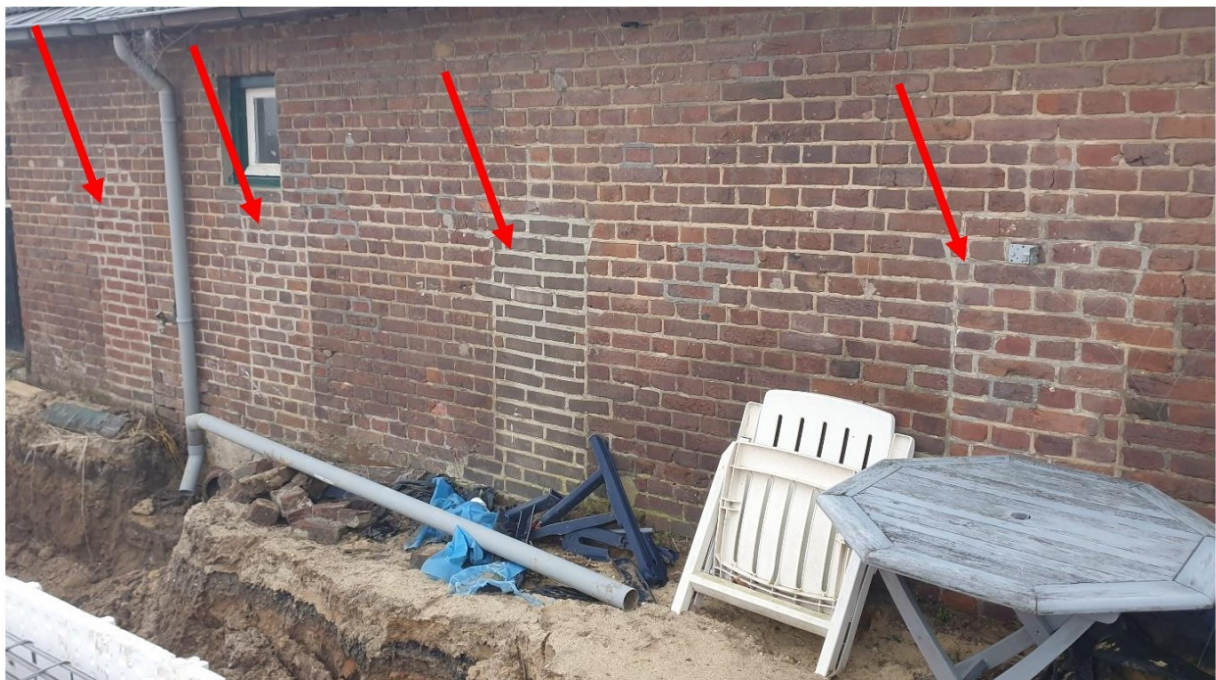
Dicht gemetselde varkensdeuren met een niet authentieke steen
