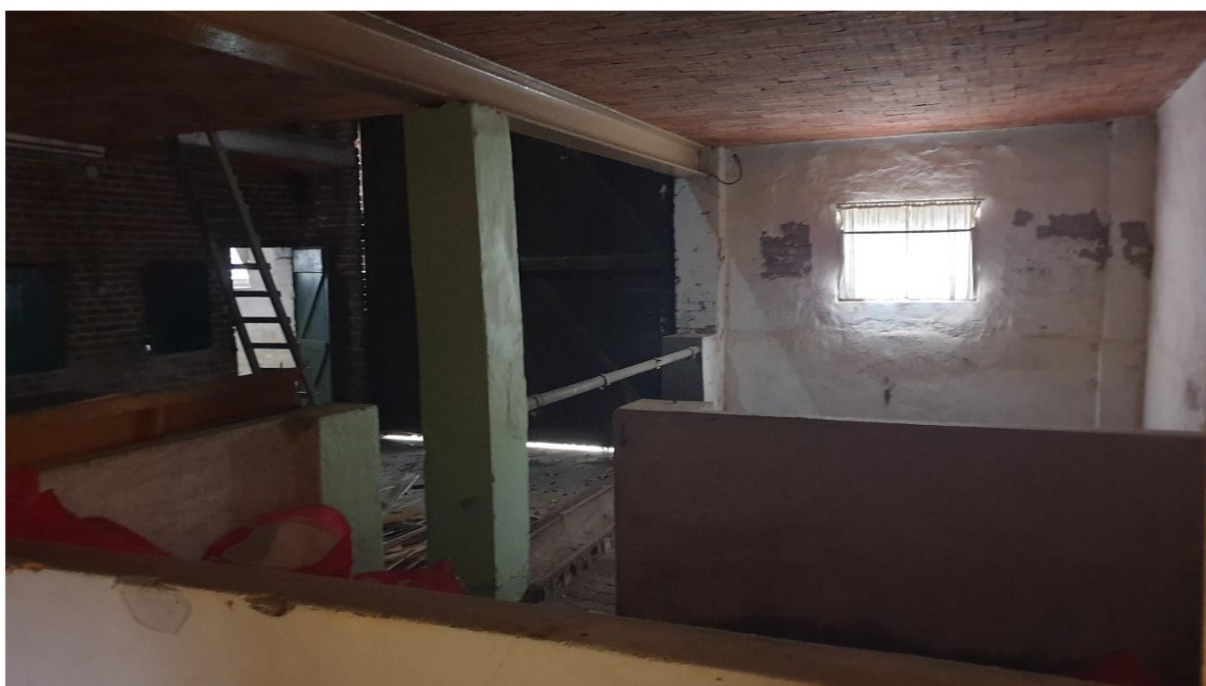
Impressiebeeld garage (oude stal) met de holle bakstenen dekvloer
