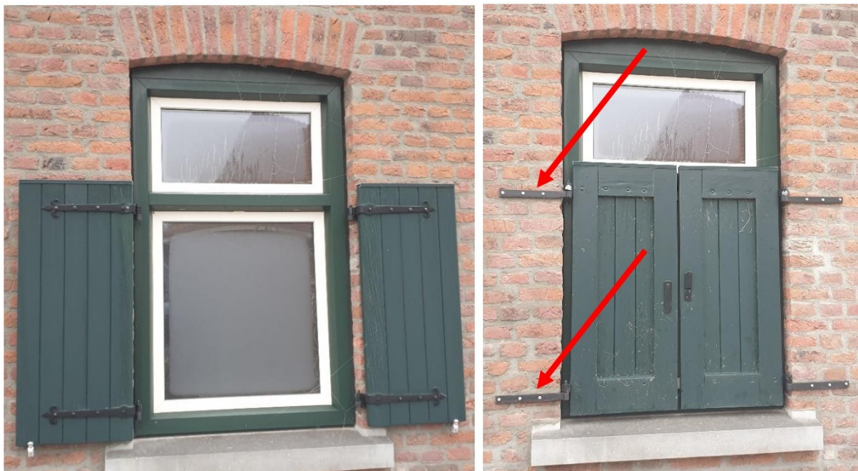
Luiken lijken niet authentiek gezien de bevestiging van de scharnieren
