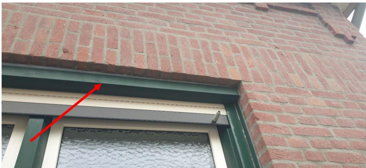
Inbouw rolluiken in de voorgevel
