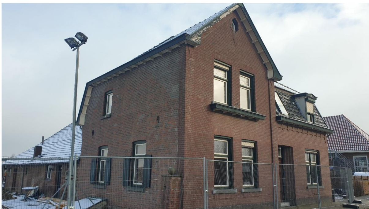
Voorgevel - linker zijgevel
