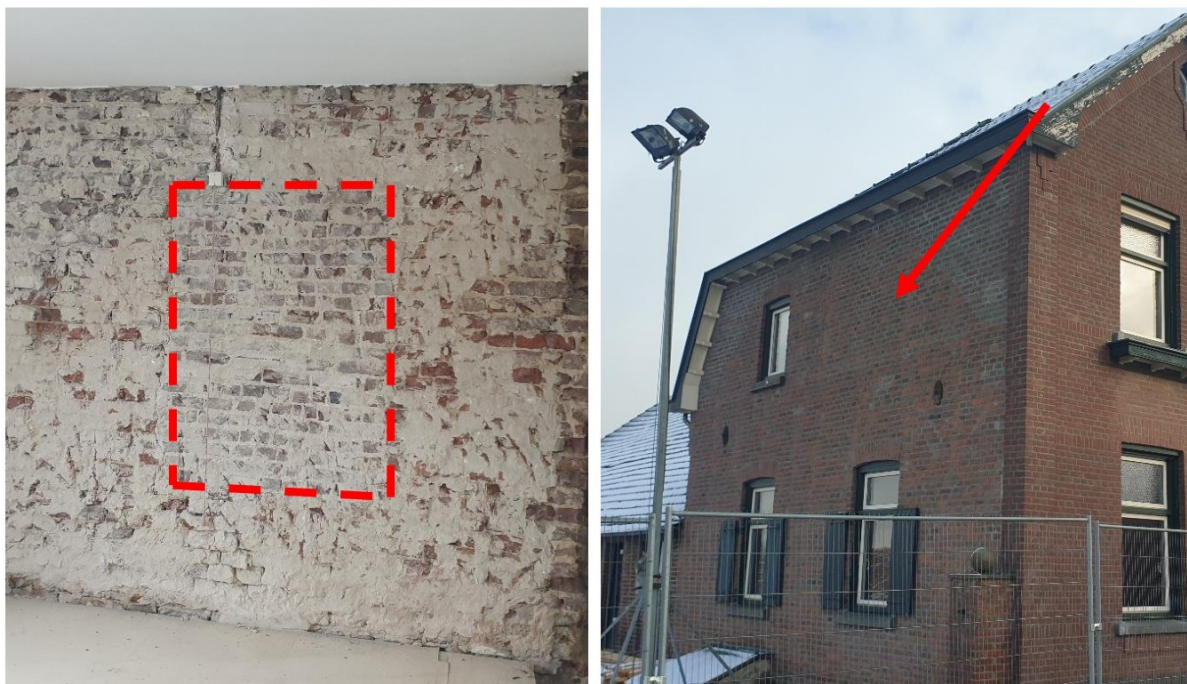
Details zichtbaar in de binnenmuur van een oud raamkozijn in de linker buitengevel.
