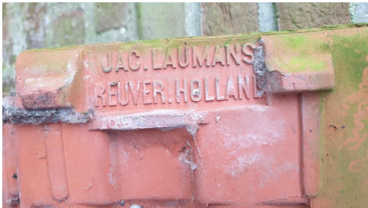
Detail dakpan schuur aanbouw
