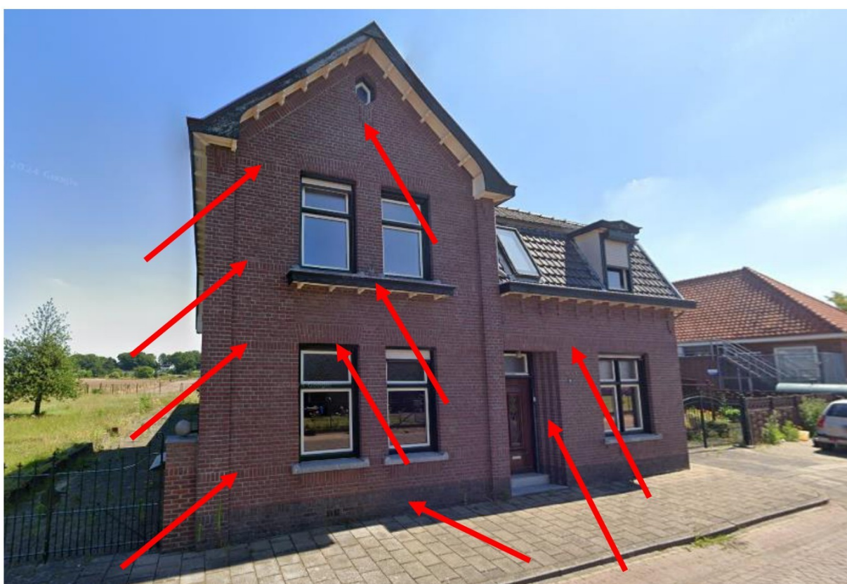
Verfraaide details in de voorgevel welke niet authentiek zijn
