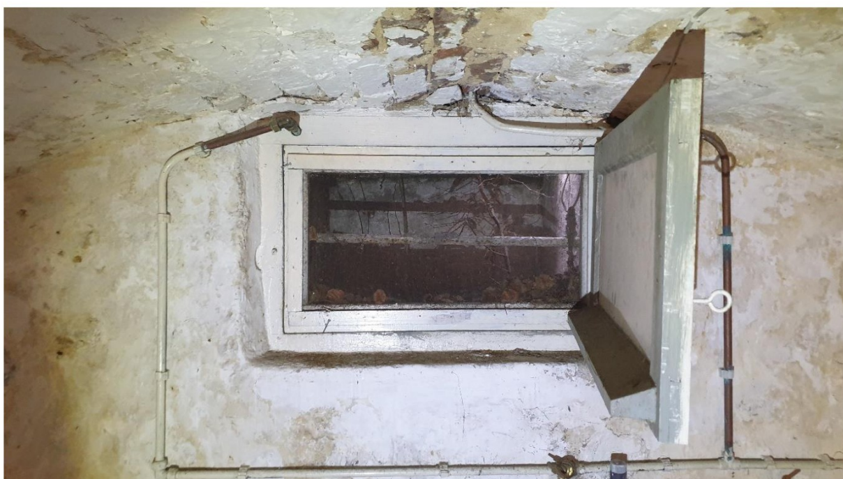
Sporen van baksteen in het gewelf van het betreffende kelderdeel.
