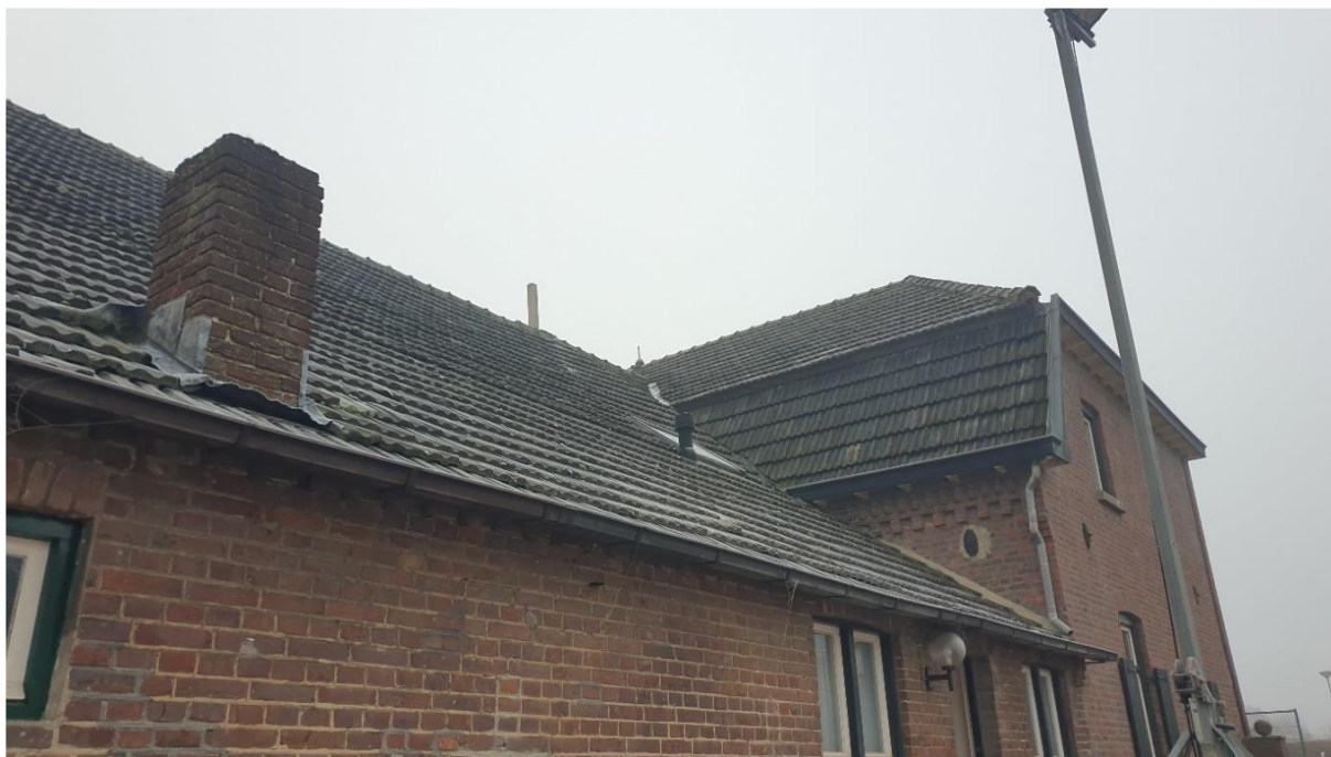
Achterzijde voorhuis en dak achterhuis
