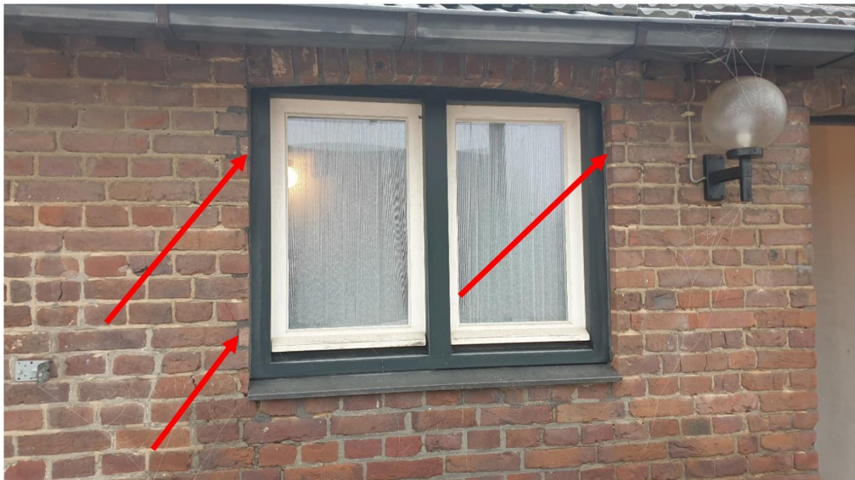
Niet originele raamopening. Zichtbaar aan zaagsnede en de klezoor stenen bij de dagzijde van de raamopening
