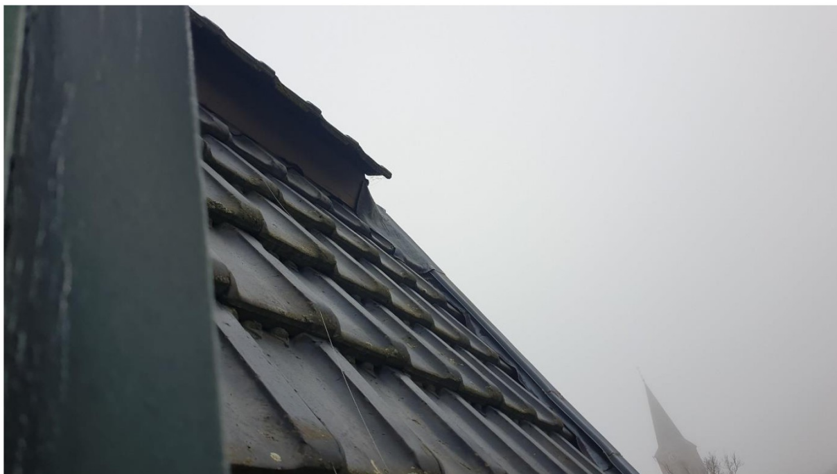
Voorzijde dak voorhuis
