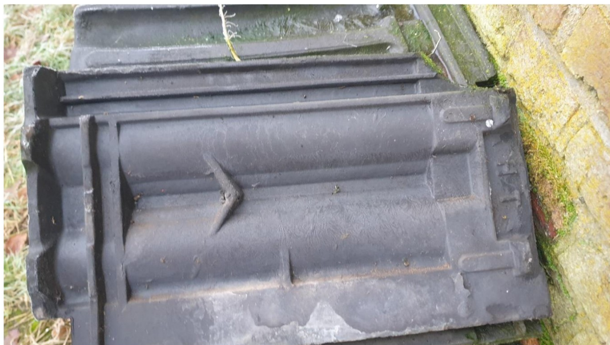
Detail dakpan aanbouw.
