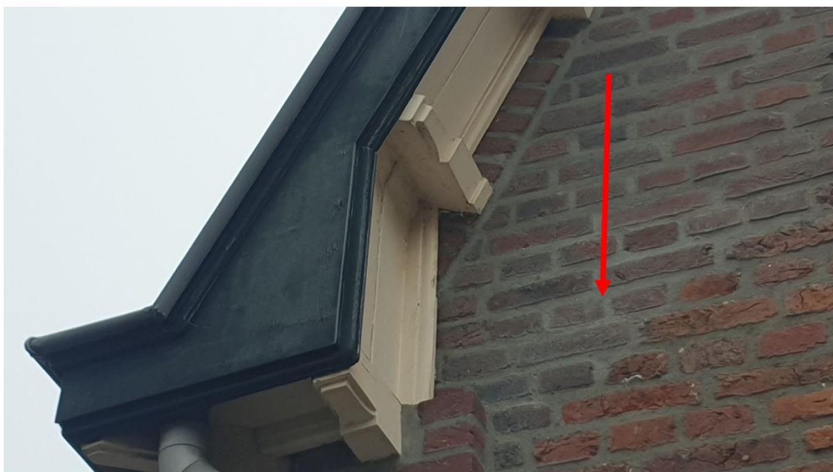
Er is gebruik gemaakt van een platvol voeg wat niet authentiek is.
