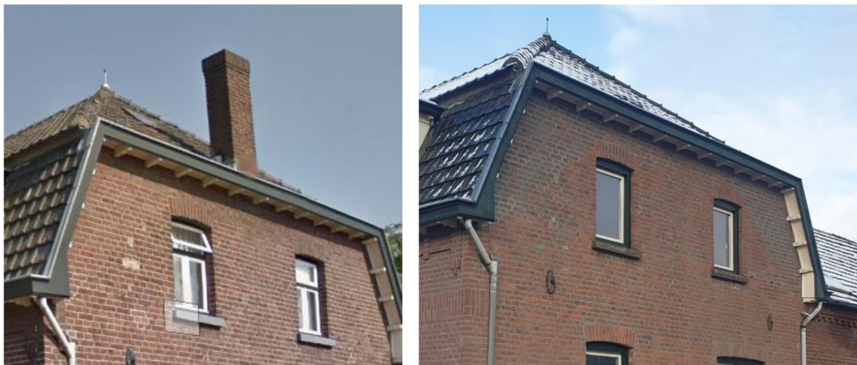
De schoorsteen is verwijderd aan beide zijde van het voorhuis
