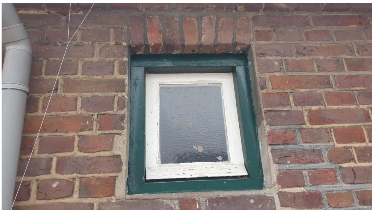
Periodiek correct raamkozijn, de betreffende gevel is echter van een latere periode.
