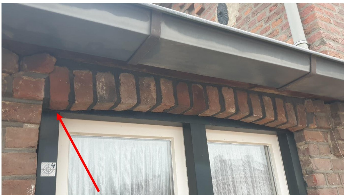
Overgemetselde en vernieuwde halfsteense segmentboog
